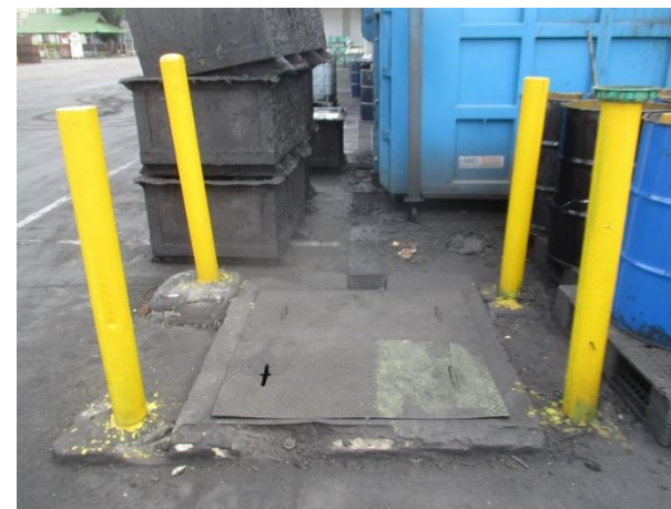
รูปที่ 2-26 บ่อค้ำน้ำมันขนาด 1.5 ลูกบาศก์เมตร
