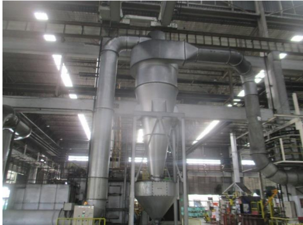
รูปที่ 2-1 ระบบบำบัดมลพิษทางอากาศแบบไซโคลนเพื่อบำบัดมลพิษทางอากาศ ที่เกิดจากเครื่องทุบขึ้นรูปขนาด 6300 ตัน
