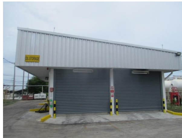
รูปที่ 2-49 การจัดเก็บสารเคมีไว้ในอาคารที่มีหลังคาปกคลุม เพื่อป้องกันการรั่วไหลลงสู่รางระบายน้ำฝน
